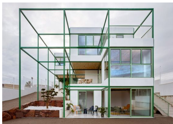
inspirace nechávající vyniknout ocelovou konstrukci
