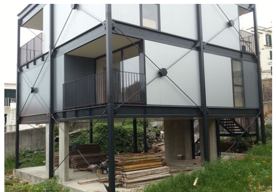
inspirace nechávající vyniknout ocelovou konstrukci
