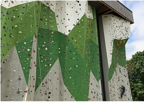
inspirace - exteriérová stěna na budově
