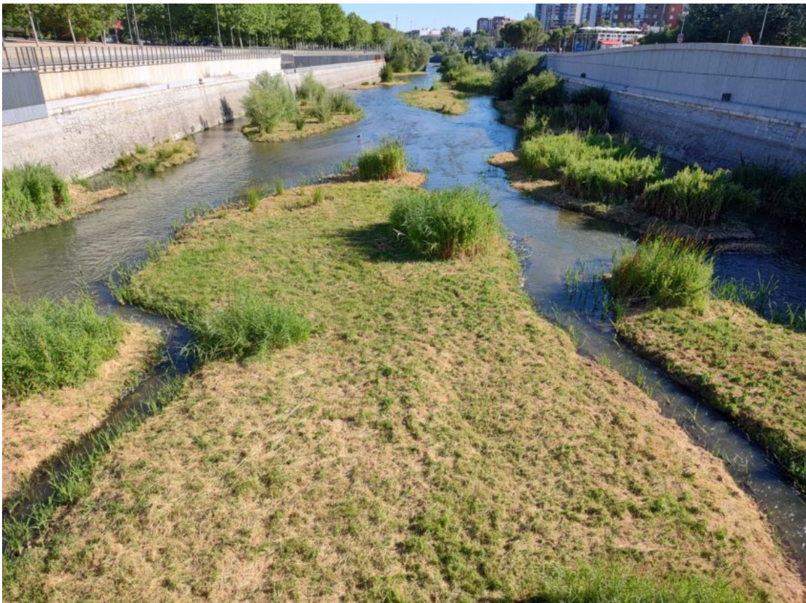
jemné strukturování vodního toku může vytvořit biologicky hodnotné, návštěvnický velmi atraktivní prostředí i na velmi malé ploše. Rio Manzanares, Madrid
